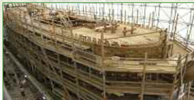
La reconstruction de l'Hermione à La Rochelle
