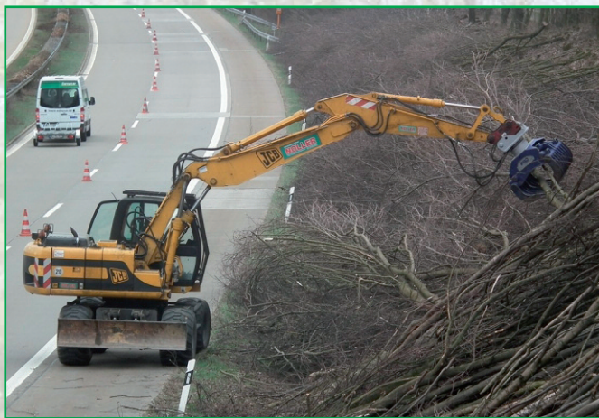
Exploitation sur autoroute. photo source WSL
