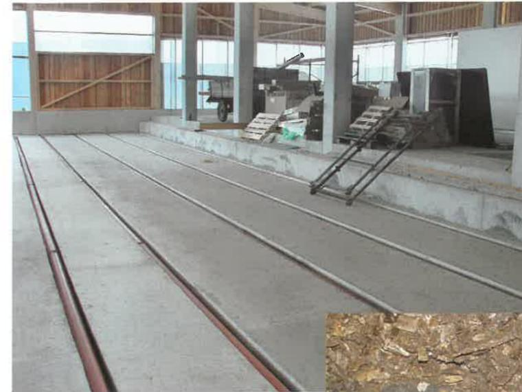
Mit einer Unterflurbelüftung kann bei guter Prozesskontrolle Arbeitszeit gespart werden. Fotos: Holzeder
