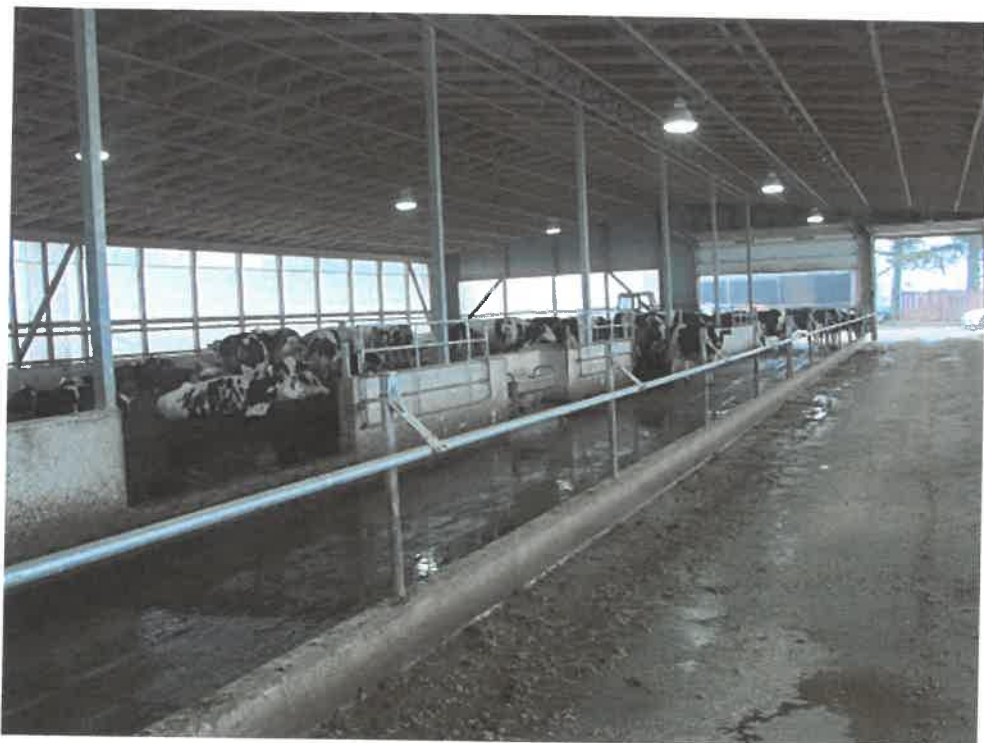
Figure 9. L'accès limité aux mangeoires permet une plus grande capacité de stockage de la litière accumulée dans l'aire de couchage.
