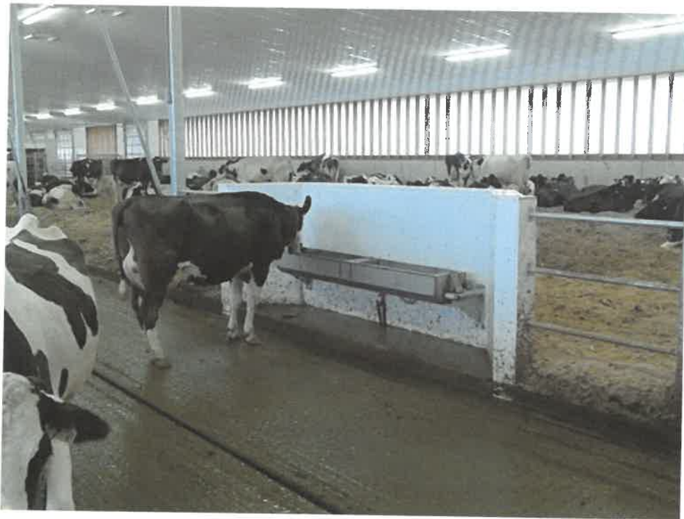
Figure 10. Positionner les abreuvoirs de sorte que la litière accumulée reste sèche.
