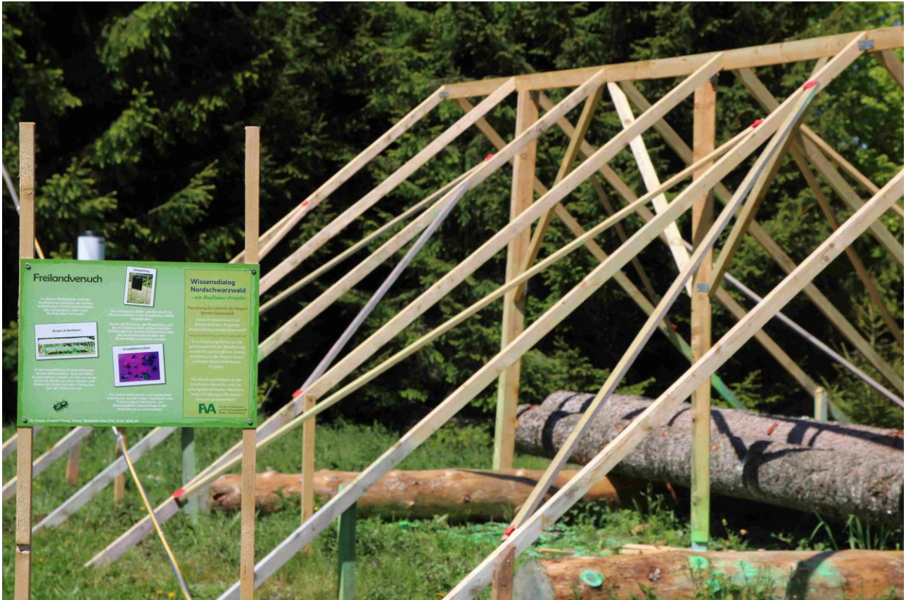
Abb. 13: Die Fanghölzer sind ausgelegt, sie wurden schon besiedelt. Der Rohbau steht, bald werden die Stämme wieder gefärbt und das Dach vervollständigt (Foto RJ 5/2017)
