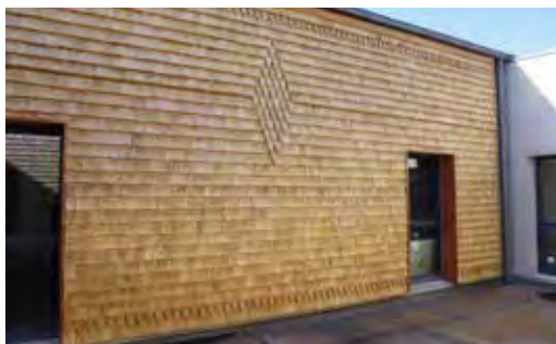
Bardeaux fendus, pose à recouvrement
