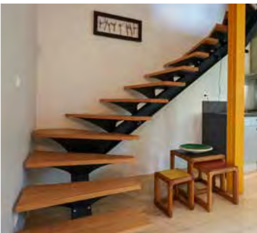
Escalier en châtaignier
