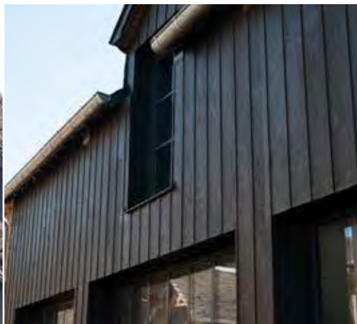
Pose verticale sur ossature bois avec couvre joint, saturateur noir et pointes inox
