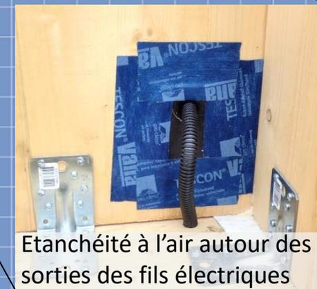
Etanchéité à l'air autour des sorties des fils électriques
